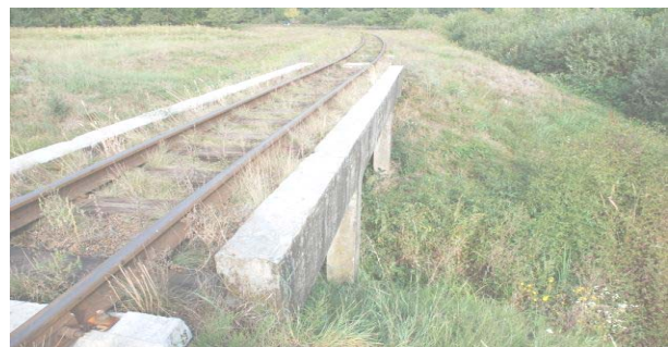
Рис. 8. Загальний вигляд мостового полотна
