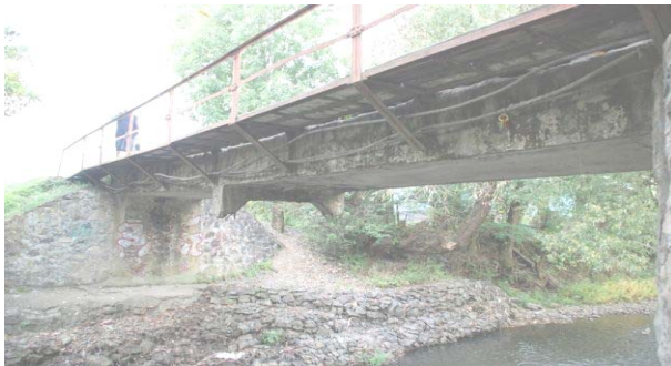
Рис. 10. Загальний вигляд мосту на ПК 429+04,9
