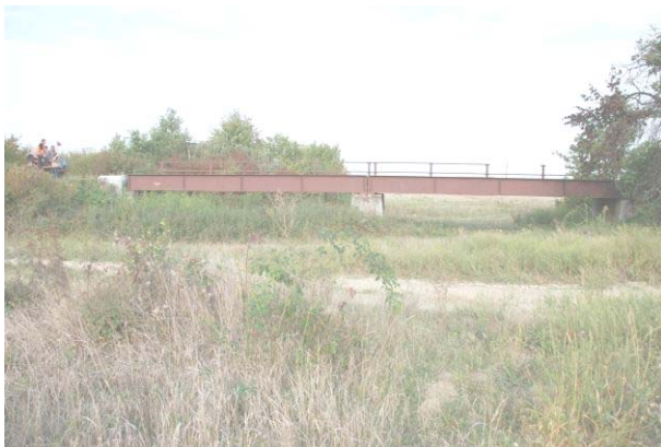
Рис. 5. Загальний вигляд мосту на ПК 183+94,1
