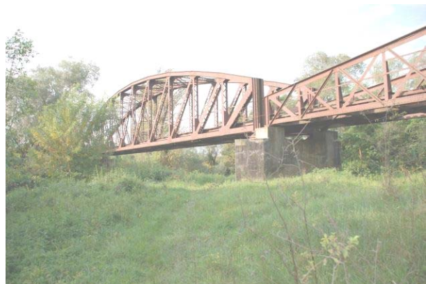
Рис. 3. Загальний вигляд мосту на ПК 191+1,4
