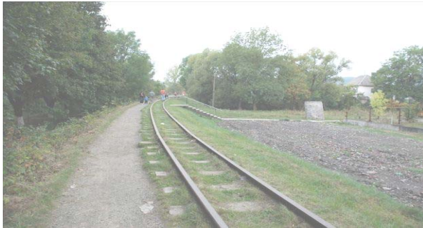
Рис. 9. Загальний вигляд залізничної колії
