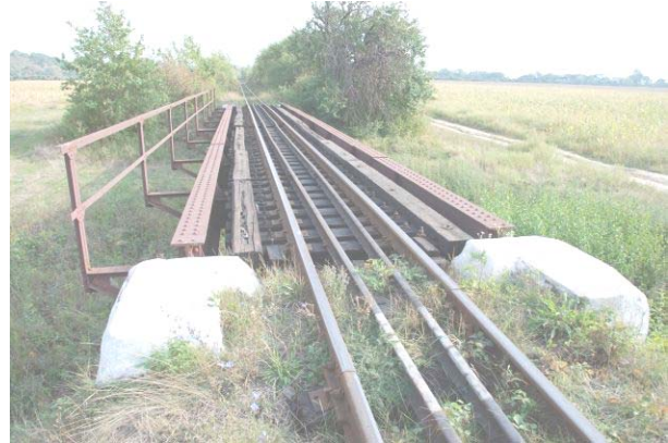
Рис. 6. Загальний вигляд мостового полотна на ПК 183+94,1.
