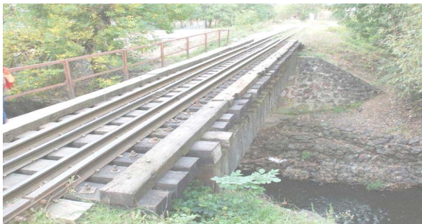
Рис. 11. Загальний вигляд мостового полотна
