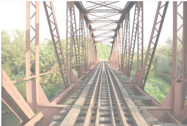
Рис. 4. Загальний вигляд мостового полотна
